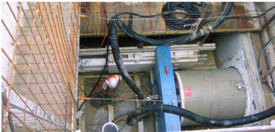
Microtunnelier à Poissy
