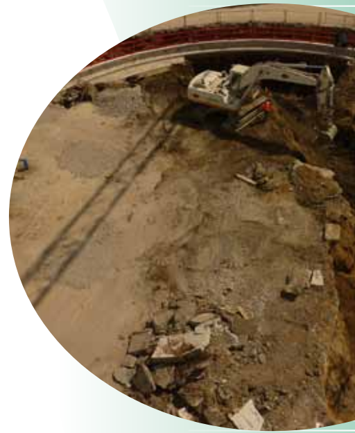
Chantier du BSR septembre 2011
